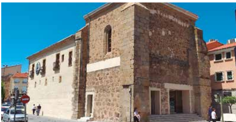
Gráfico 5-14. Caso de éxito cinco. Edificio después de la rehabilitación
