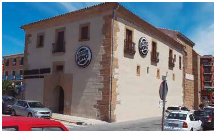
Gráfico 5-13. Caso de éxito cinco. Edificio después de la rehabilitación
